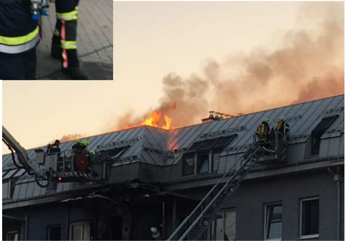
Die Brandherde in den Wohnungen wurden gelöscht, jetzt musste die Brandausbreitung am Dachstuhl verhindert werden.
