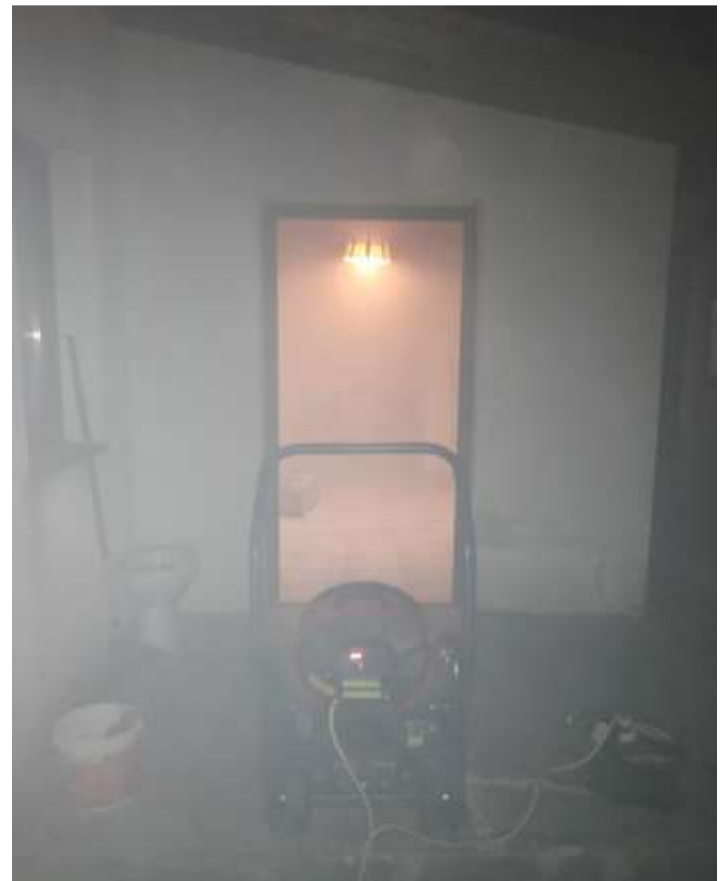
Arbeiten mit dem Druckbelüfter in der Bodenzeile
